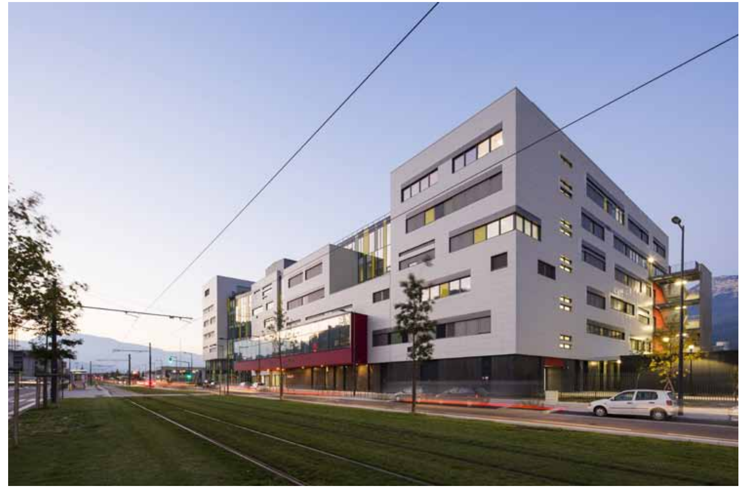
Vue Nord Ouest depuis l'avenue des Martyrs
