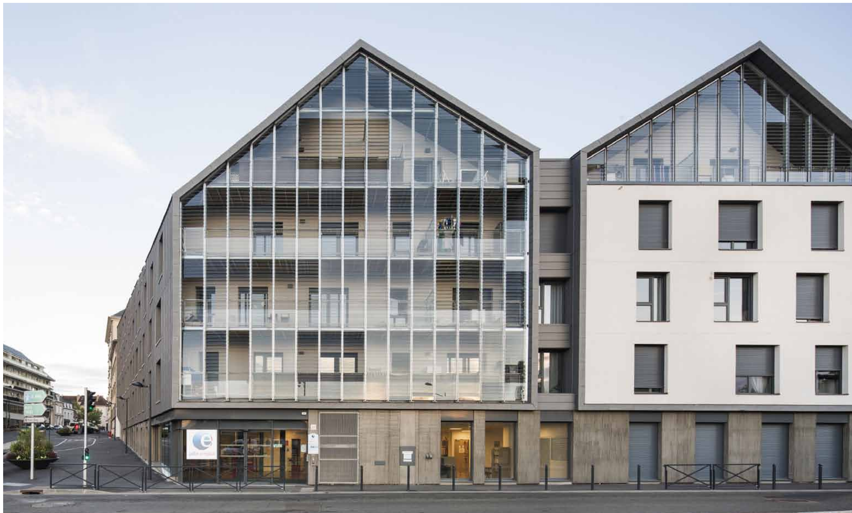
La peau plissée en zinc pré-patiné définit une enveloppe identifiable, contemporaine, qui dialogue avec l'architecture du centre ancien de Chartres, ses toitures et ses pignons.
