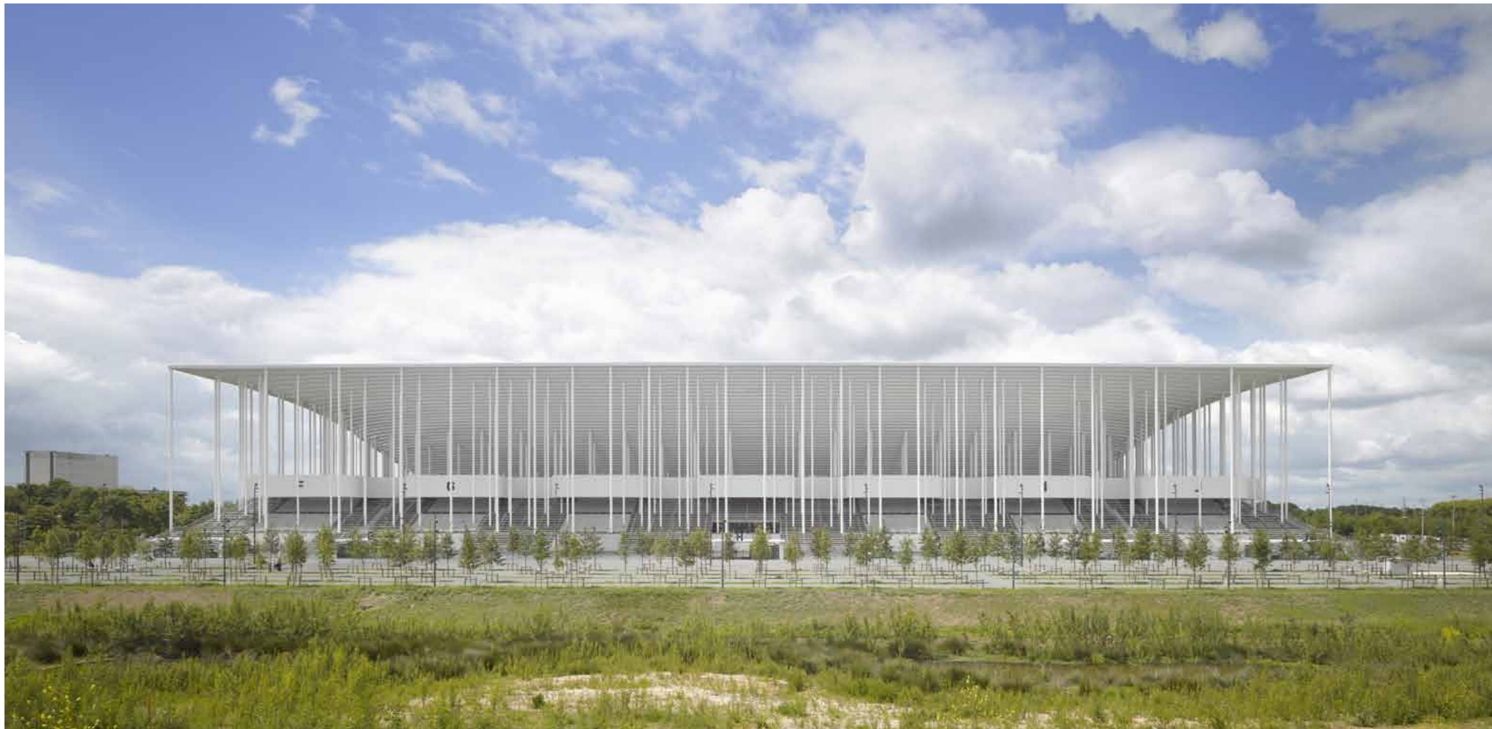
Le rectangle blanc que constitue la toiture est comme rattaché au sol par une pluie de colonnes élancées.
