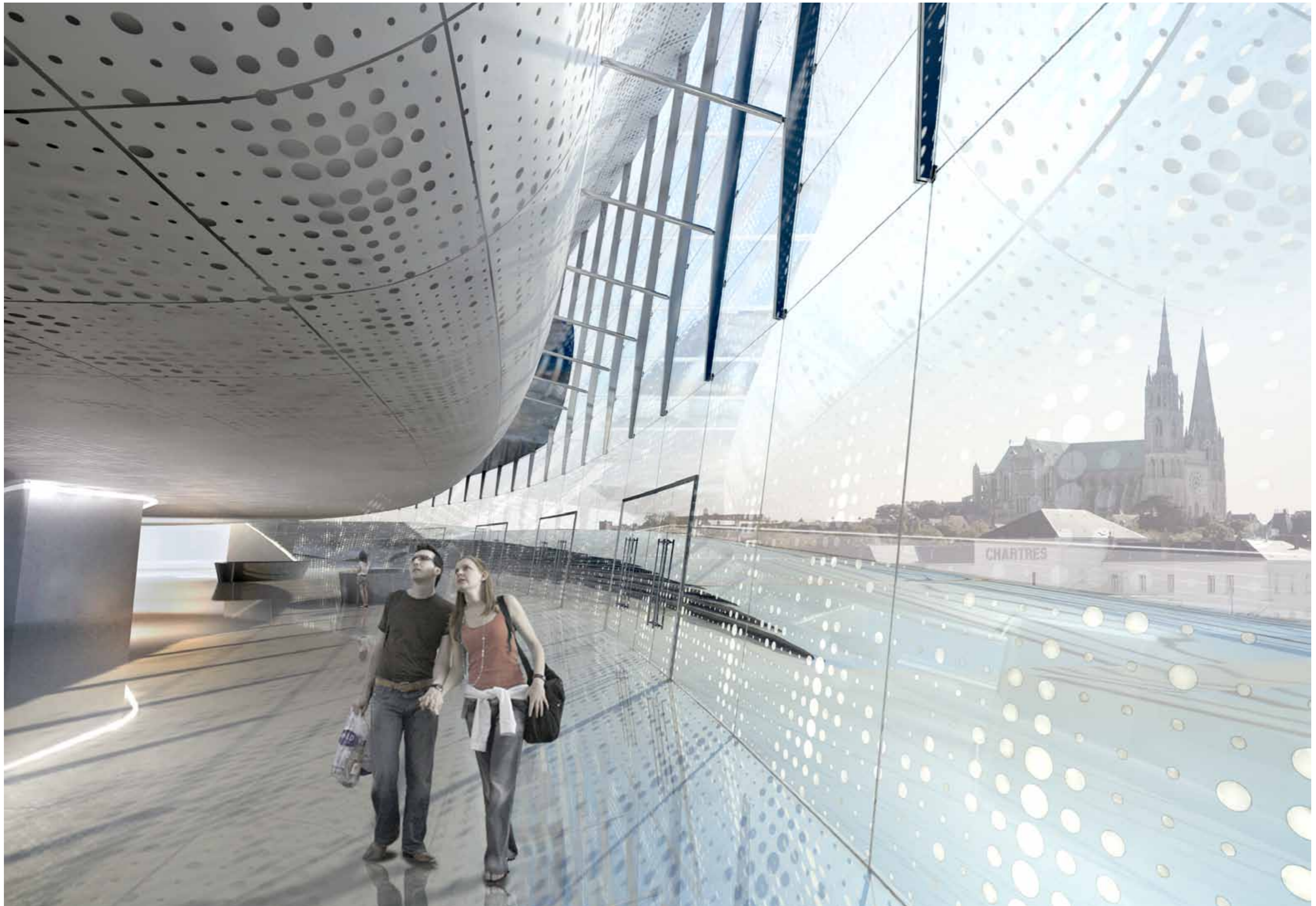
Le hall, avec sa double peau en verre pincé, en transparence sur la ville, permet l'accès à mi-niveau au coeur de la salle
