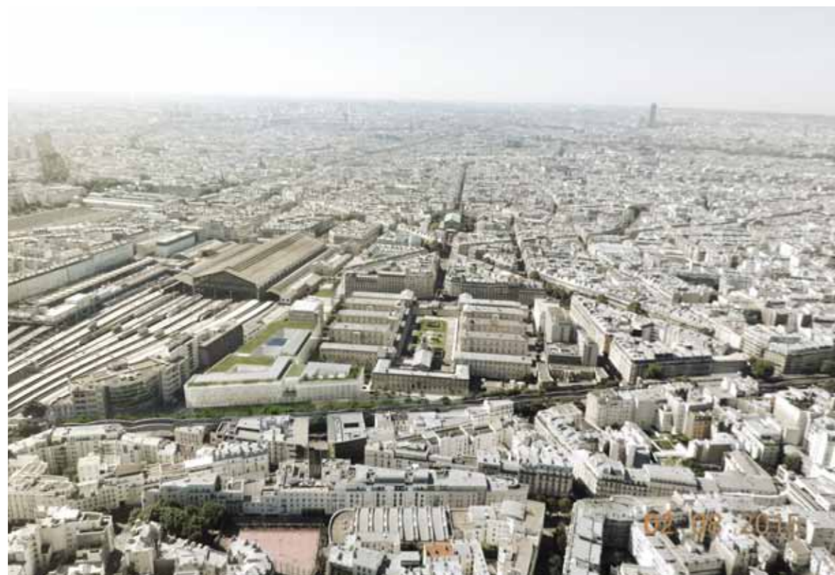
La réalisation du Nouveau Lariboisière est un acte fondateur de la mutation de l'Hôpital dans son territoire. Il restaure une relation harmonieuse avec la ville.
